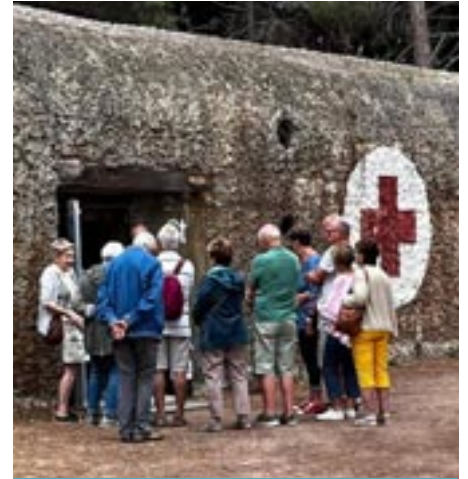
Le bunker infirmerie 638 à la tamarissière
