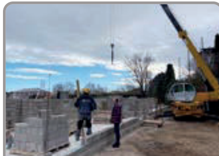
Vincent Gaudy se déplace régulièrement sur les chantiers en cours pour s'assurer de leur bon déroulement
