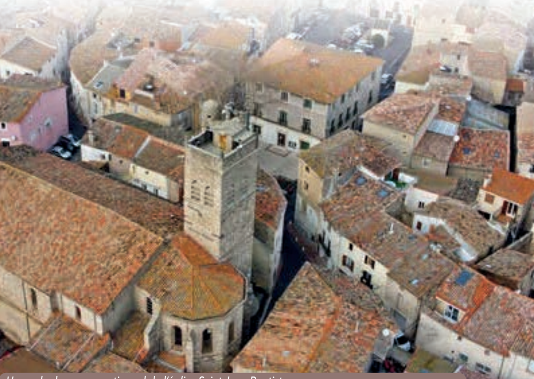
Un angle de vue exceptionnel de l'église Saint Jean-Baptiste. Cliché réalisé en décembre dernier par un drone à l'occasion de l'inspection des toitures
